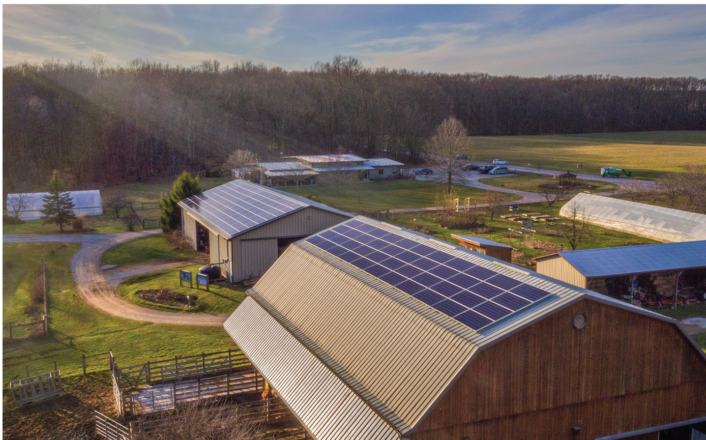
Paneles solares en la azotea de los graneros en Stratford Ecological Center, una granja orgánica educativa sin fines de lucro y reserva natural. © Above the Light Photography
