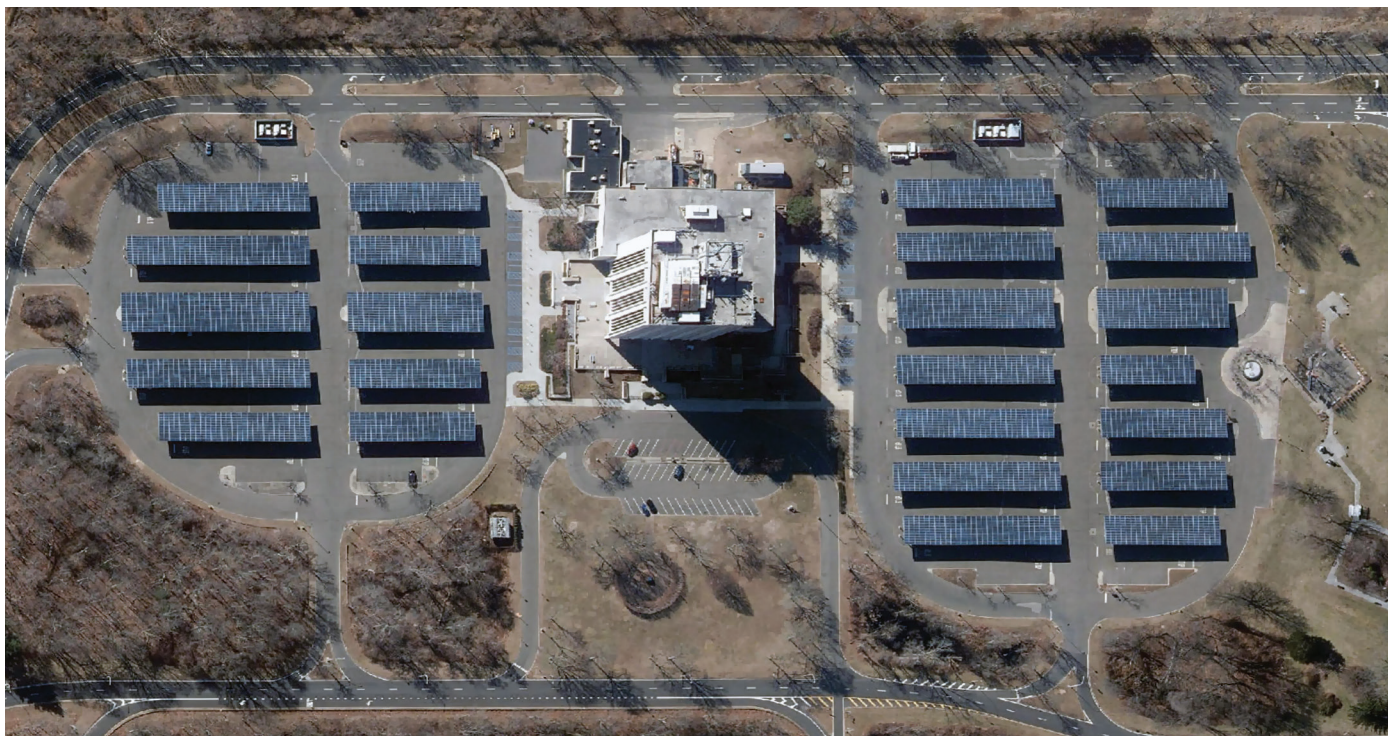
Vista aérea del conjunto de paneles solares de 1.750 kW en el estacionamiento del edificio H. Lee Dennison del condado de Suffolk en Hauppauge. El condado de Suffolk ha instalado paneles solares en seis estacionamientos del condado, y en edificios de siete instalaciones del condado. © Departamento de Planificación y Desarrollo Económico del Condado de Suffolk
