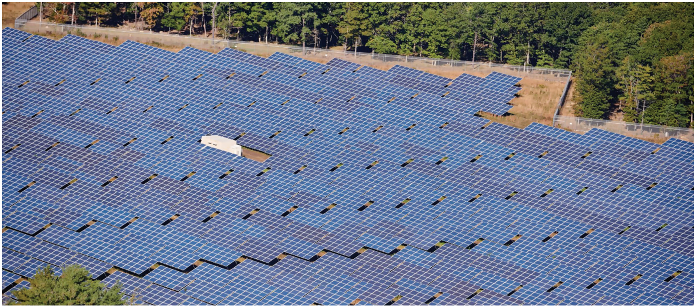
La granja solar de 32 MW en el laboratorio Nacional de Brookhaven en Long Island se construyó mediante una colaboración entre BP Solar, la Autoridad de Energía de Long Island y el Departamento de Energía de EE.UU. © Flickr
