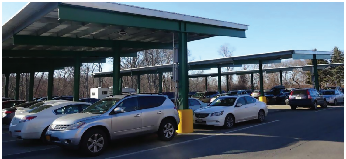
Las marquesinas solares cubren el estacionamiento en el Centro Médico de Veteranos de Northport. © Sunshine Plus Solar
