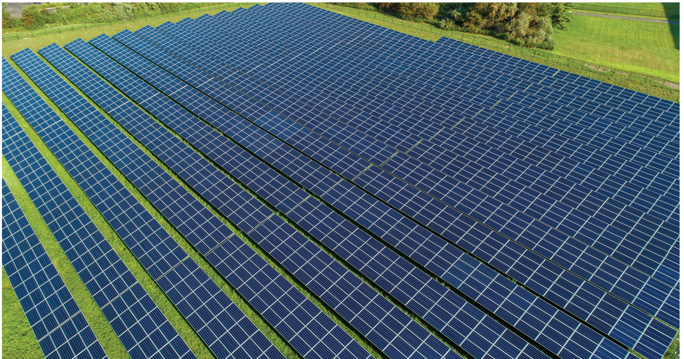
Paneles de energía solar montada sobre el suelo en el campus de las empresas de Estee Lauder en Melville, NY. © EmPower Solar
